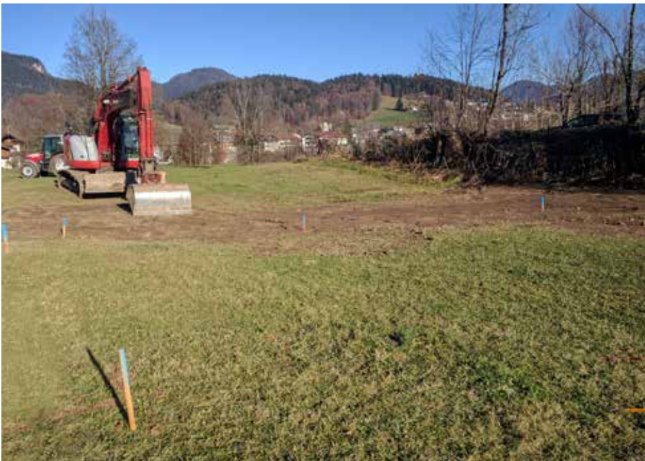
Hier können künftig zwei Doppelhaushälften bzw. drei Einfamilienhäuser entstehen.
