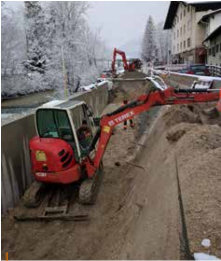
Die Bauarbeiten an der B20 gehen wie geplant voran.
