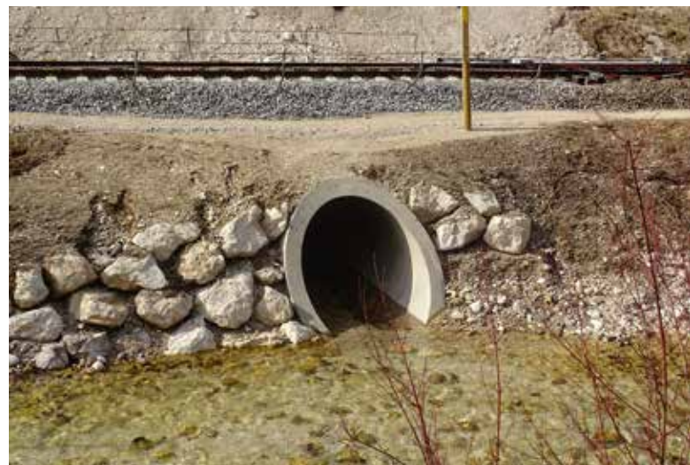
Ein neuer Ableitungskanal führt nun vom Reissengraben bis zur Bischofswieser Ache.
