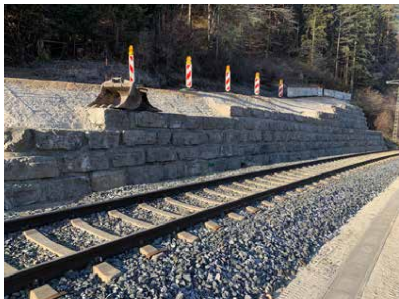
Am Erbmühlweg wurde die Straße wiederhergestellt und eine neue Stützmauer errichtet.
