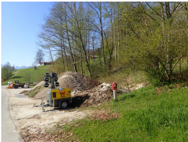
Abbildung 5: Der Geltungsbereich wird z.T. als Lager für Baumaterialien genutzt.
