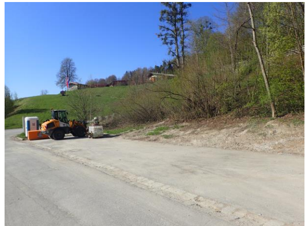
Abbildung 6: Blickrichtung von Osten auf den Geltungsbereich mit geräumter Lagerfläche von Baumaterialien.
