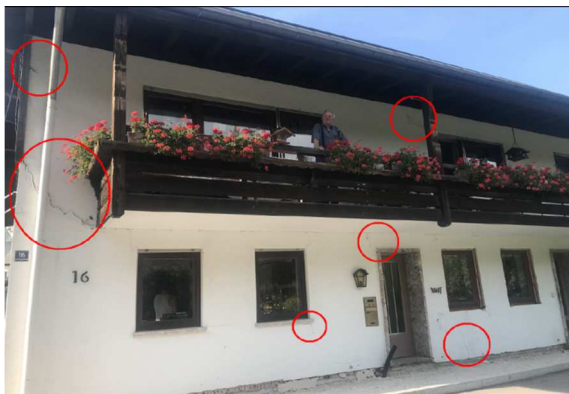
Abbildung 8: Fassade mit Rissbild und Wand in der Werkhalle
