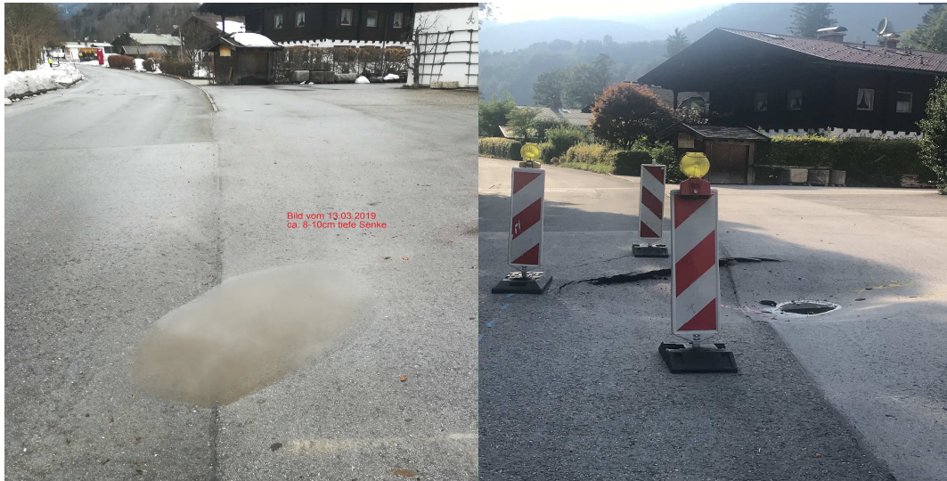
Abbildung 10: Entwicklung der Absenkung 03.2019 bis 08.2019
