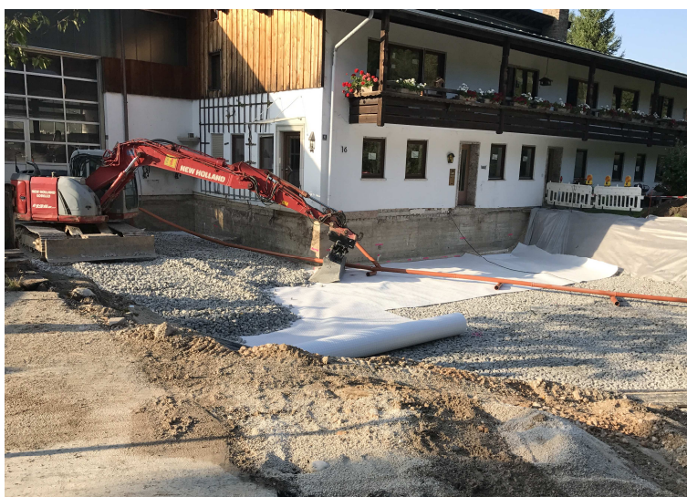
Abbildung 9: Einbau des mit Geogitter bewehrten Kieskoffers 09.2017
