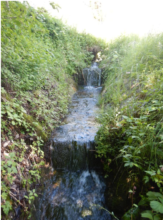
Abbildung 4.4: Sohlriegel Stangerriegelbach Graben (aquasoli 2022)
