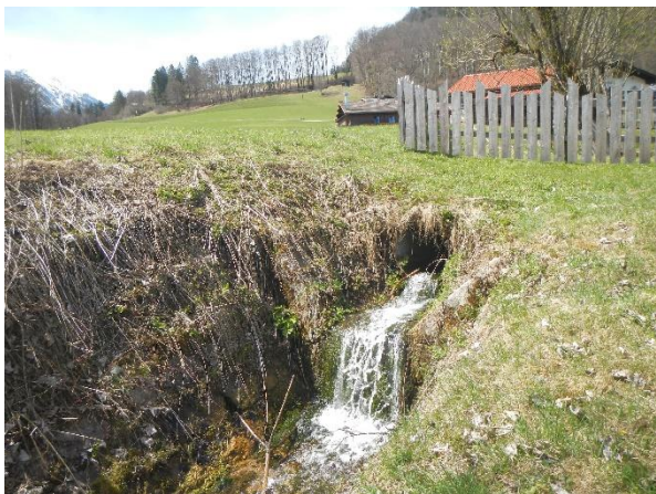
Abbildung 2.8: Auslauf Verrohrung DN700. Beginn Planungsbereich (aquasoli 2022)
