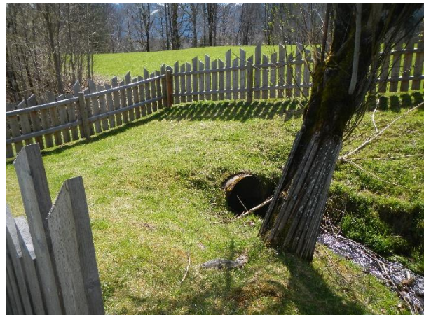
Abbildung 2.7: Einlauf Verrohrung DN700. Oberstrom Planungsbereich (aquasoli 2022)
