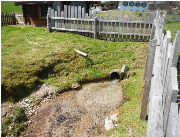
Abbildung 2.6: Auslauf Verrohrung Höhe Stöberl (aquasoli 2022)
