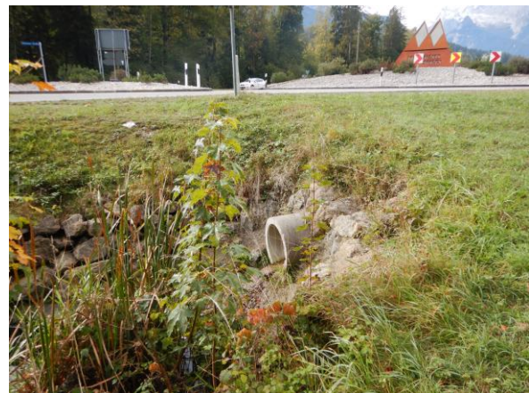
Abbildung 1.10: Ausauf Verrohrung DN800 Höhe Kreisverkehr
