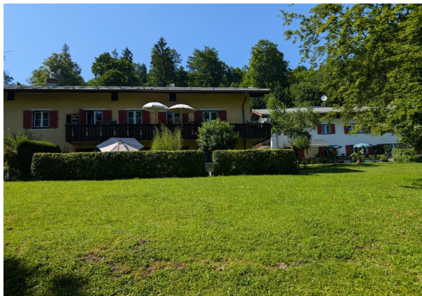
Abb. 12: Grünfläche vor den Altbaugebäuden
